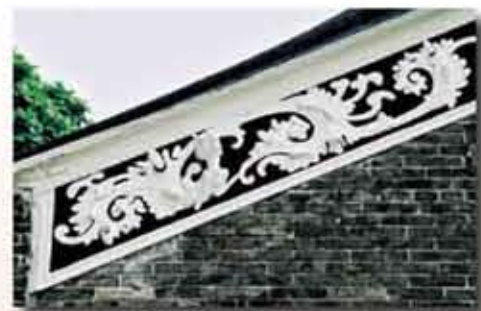
山牆上的草尾灰塑裝飾 Mouldings of leafy patterns on the gable wall
