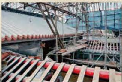
修復工程進行中 Restoration work in progress
