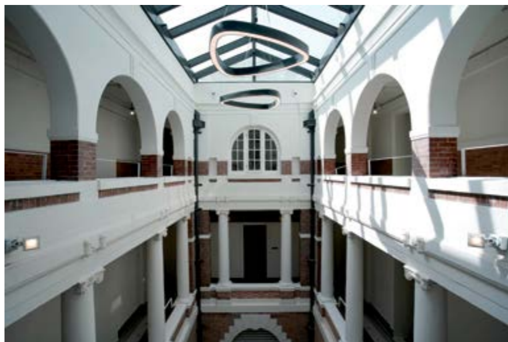
圖10 修復中庭。 上：修復前的狀況：當大樓改建為終審法院時，加建了鋼製的升降機豎井，連接底層和一樓。 下：修復後的狀況：舊天窗被新建的金字塔型天窗取代，舊升降機亦被拆除。 [來源：Design 2 (HK) Limited]
