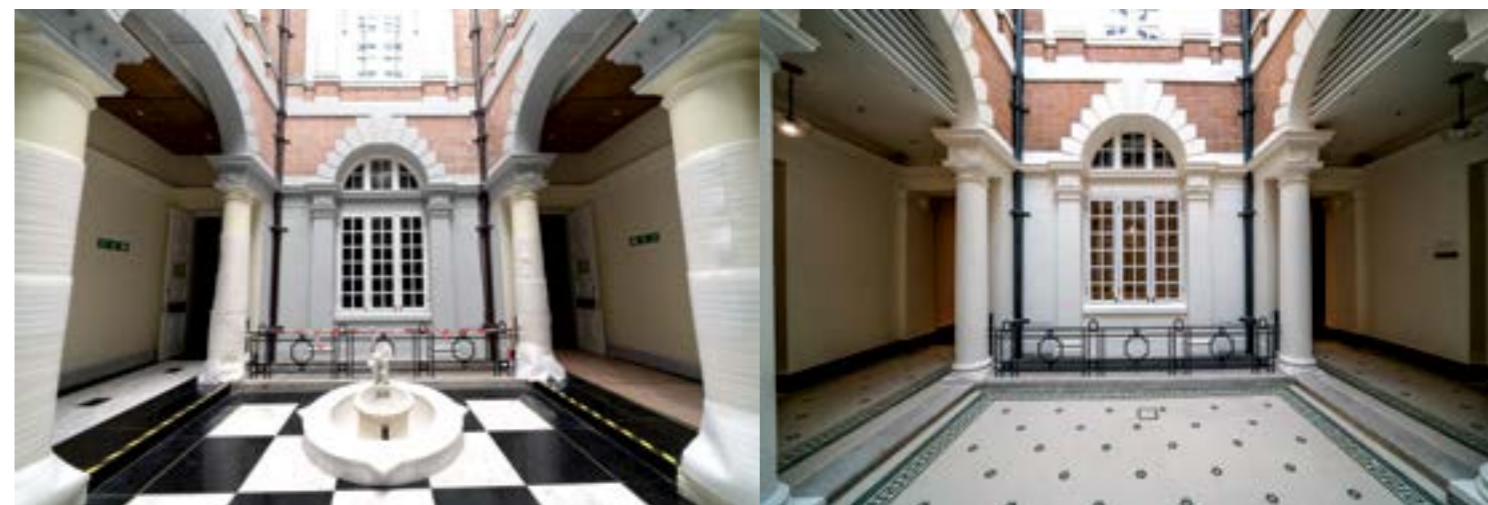
圖9 修復中庭。 左：修復前的狀況。 右：修復後，後加部件被拆除。 [來源：Design 2 (HK) Limited]
