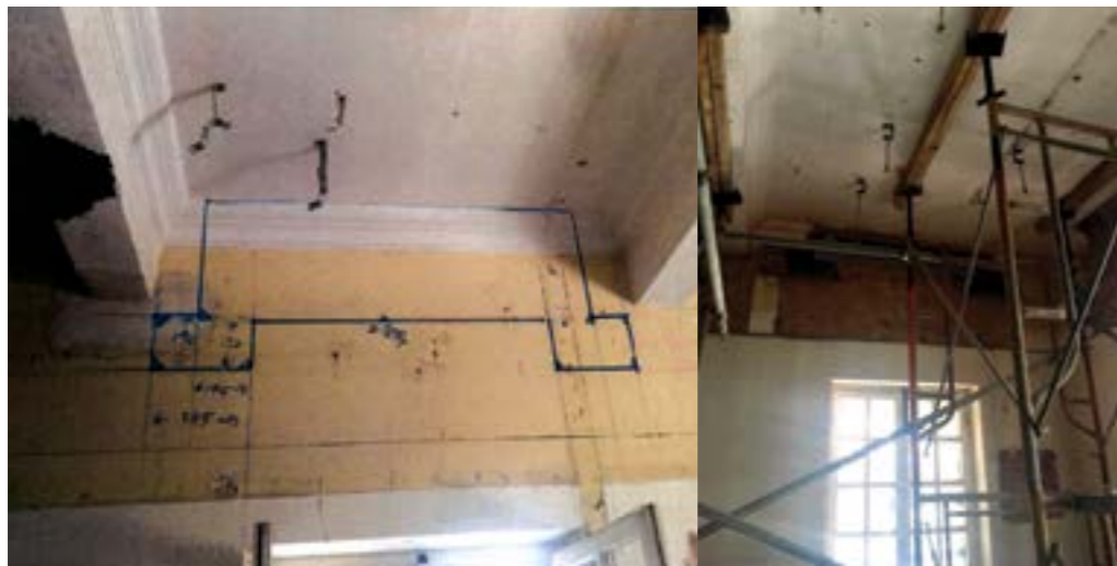
圖14 在原主力磚牆上加裝新的鋼製結構構件。 左：將每個構件的位置準確標示在主力磚牆上。 右：新的鋼製結構構件安裝在原有的主力磚牆上。只移除受影響的磚塊，並小心保存其周邊的磚塊。 [來源：合利營造有限公司]
