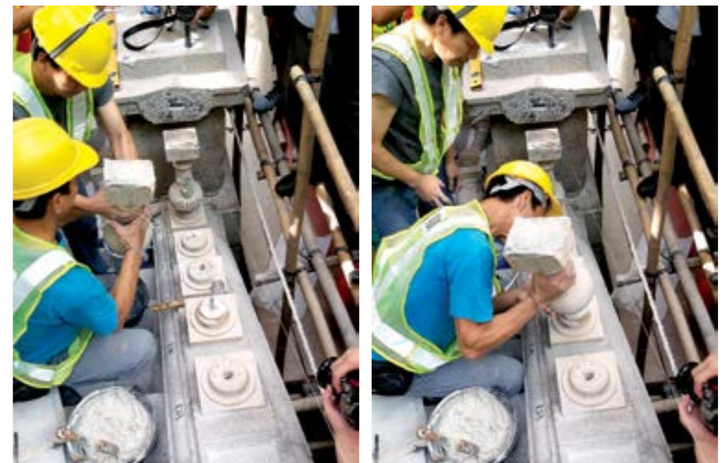
圖17 將不銹鋼杆裝在欄杆柱內進行加固。
