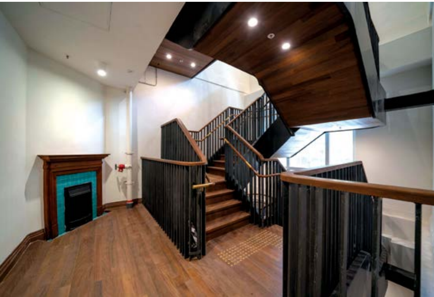
圖16 新的逃生樓梯。 左上：項目進行前的狀況：終審法院時代用作辦公室的房間。 右上方和下圖：改造後的狀況：逃生樓梯的設計與無障礙升降機一樣，採用可識別的原則，不同的材料（鋼材）及不同的形式（圓角），視覺上與室內牆壁保持距離。 [來源：Design 2 (HK) Limited]
