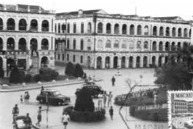
圖2-1 澳門議事亭前地整治前
