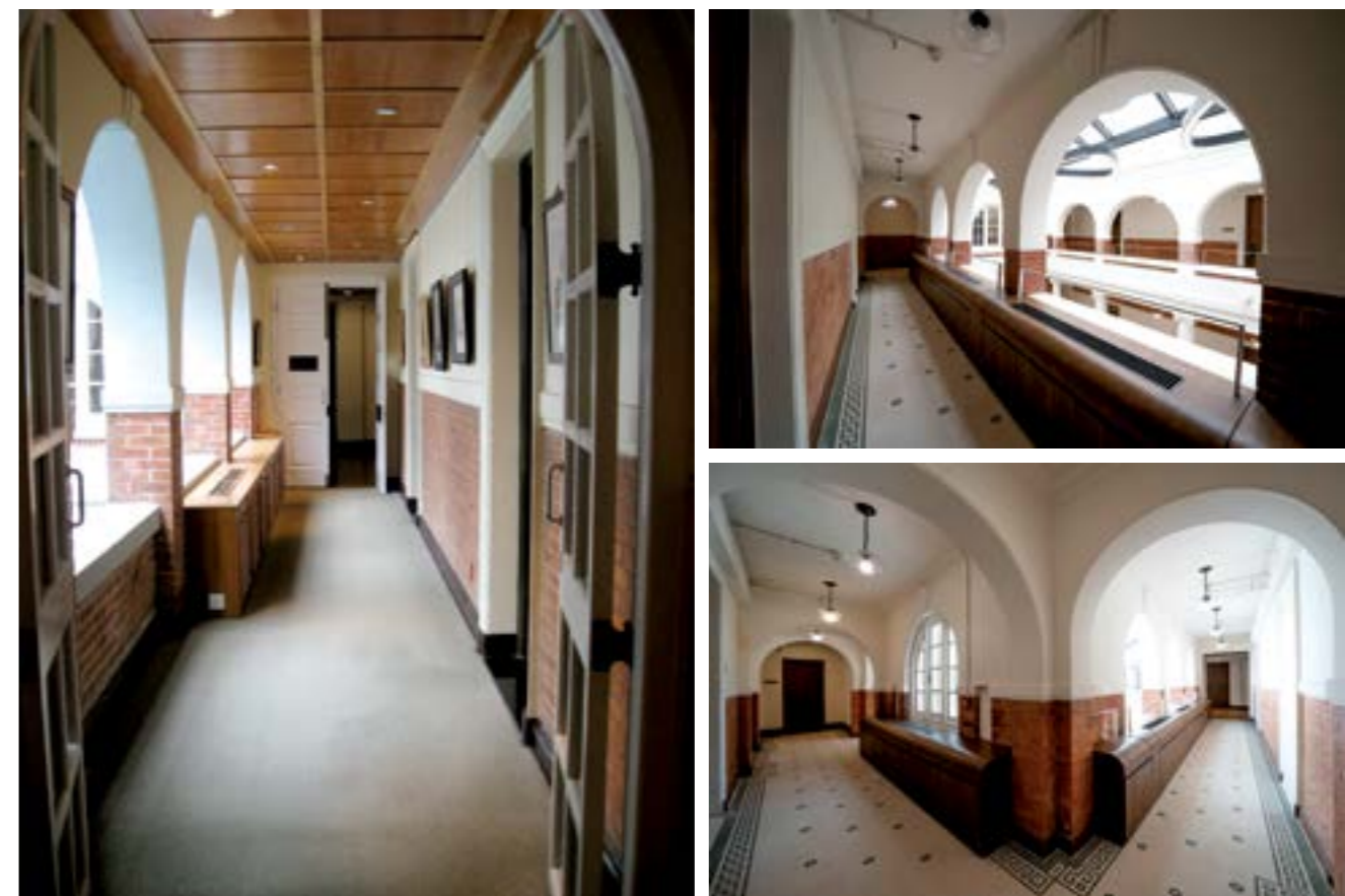
圖11 修復圍繞中庭的走廊。 左：修復前的狀況：部分拱頂石被木製天花遮蔽，地面被地氈覆蓋，一扇後加的門將走廊和大堂分隔。 右上和右下：修復後的狀況：與遊廊一樣，這些走廊原本被設計成半露天的區域，如今被重新鋪上紙皮石地磚。沿走廊可暢通無阻直達大堂。 [來源：Design 2 (HK) Limited]
