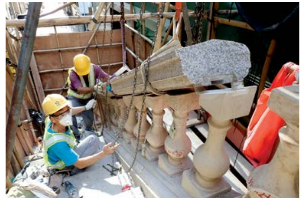
圖18 工匠使用鏈式起重器和手動工具重新安裝欄杆。
