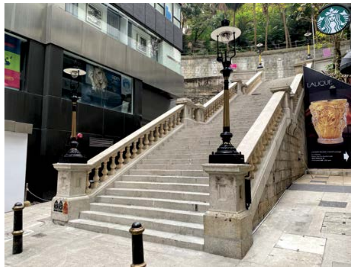
圖2 修復後的都爹利街石階及煤氣路燈。
