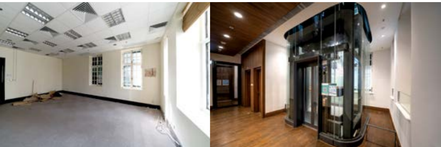
圖15 新的無障礙升降機。 左：項目進行前的狀況：大樓北面角落的一個房間，在終審法院時代用作辦公室。 右：改造後的狀況：透視的設計理念，是讓自然光線由周圍的窗戶照進升降機內。 [來源：Design 2 (HK) Limited]
