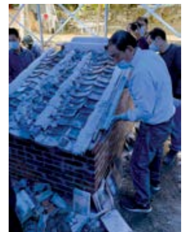
圖11b 嶺南屋頂鋪瓦技巧工作坊 註：曹凱雲拍攝
