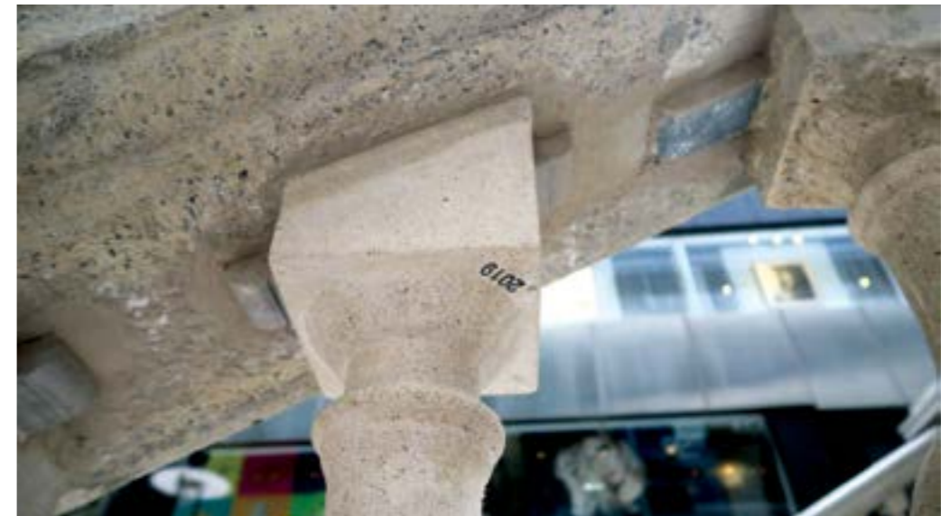
圖16 在新鑄造的水泥欄杆柱隱蔽位置印上生產年份「2019」。
