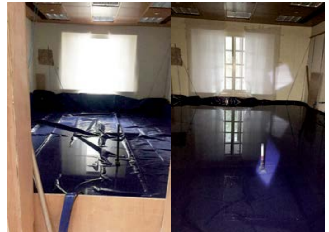
圖17 在一樓房間進行荷載測試。現有的樓板將被拆除，以建造新的逃生樓梯。 [來源：合利營造有限公司]
