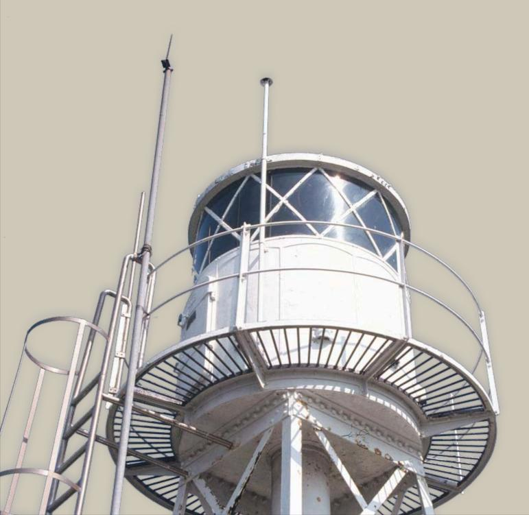
龍洲燈塔位於香港島以西一個小島燈籠洲之上,亦稱為汲星燈塔。是香港現存五座戰前燈塔的其中一座。燈塔高11.8米、由鋼鑄骨架建成,塔頂髹上白色,於1912年4月29日啟用。鋼架及照明儀器均為英國製造。以往的燈塔管理員居於燈塔旁的磚構建築,內設睡房、廚房、廁所及儲物室各一。由於島上並沒有井水或食水供應,因此只能從屋頂收集雨水,再將雨水引入地下儲水箱備用。燈塔現時已改為自動操作,無須派員駐守。燈籠洲燈塔現由海事處管理。
