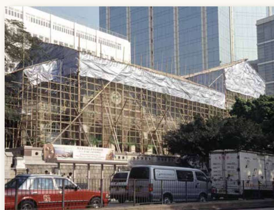
修復工程進行中 Restoration in progress
