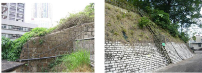
1.1) 面向青山道和位於上區的粗石擋土牆，以及該址內的支撐斜坡
