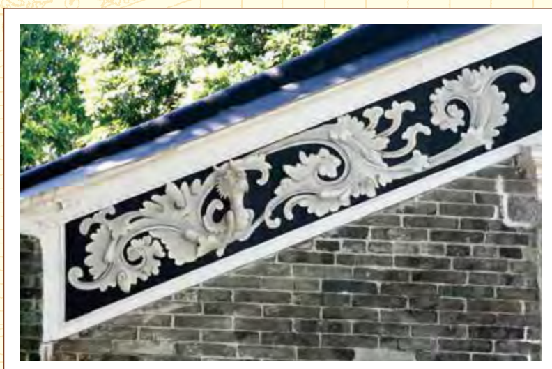
山牆上的草尾灰塑裝飾 Moulding of leafy patterns on the gable wall
