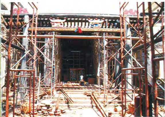
敬羅家塾復修工程。 Restoration work of King Law Ka Shuk.
