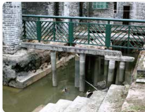
不穩固的花崗石平台 Unstable granite deck
