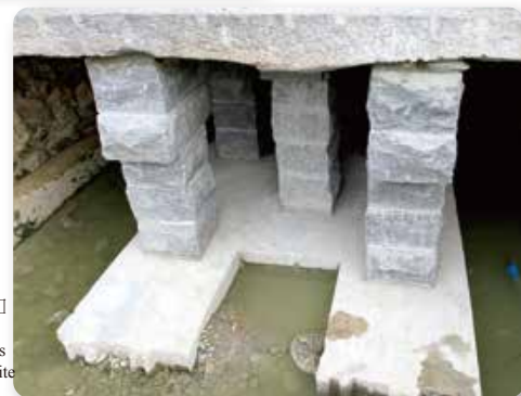
不穩固的花崗石平台 Unstable granite deck
