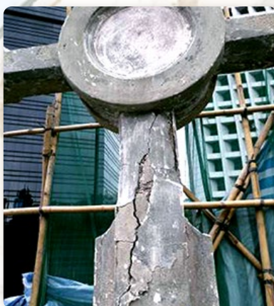
近攝下的裂痕 Close-up of cracks
