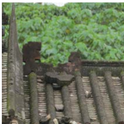
屋脊上的「博古」裝飾（修復前後） Bogu stucco moulding on the roof ridge (before and after restoration)
