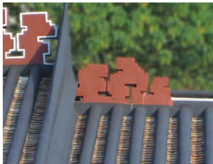
屋脊上的「博古」裝飾（修復前後） Bogu stucco moulding on the roof ridge (before and after restoration)
