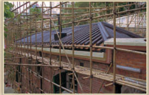
香港醫學博物館正進行修繕工程
