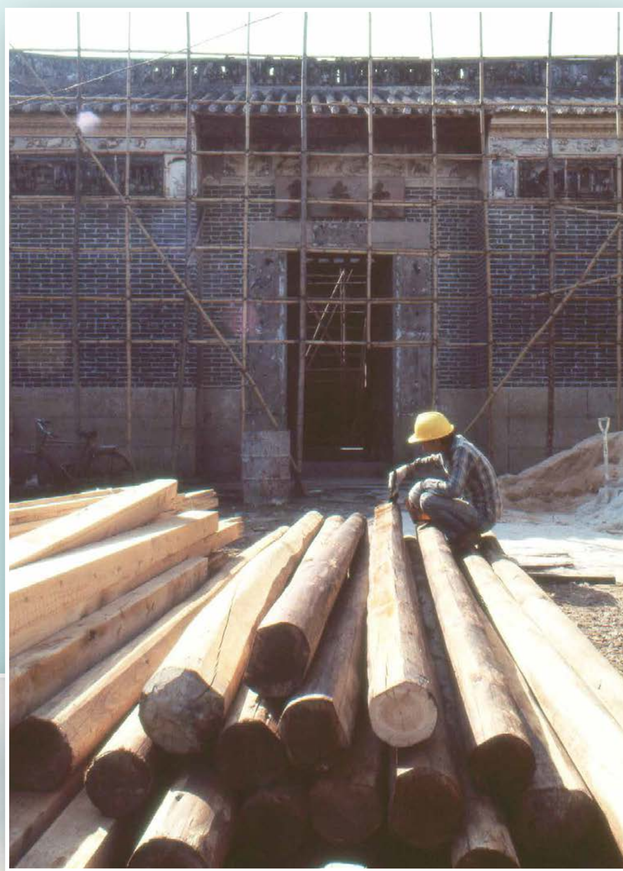
大夫第於1988年展開修復工程 Restoration work on Tai Fu Tai Mansion commenced in 1988
