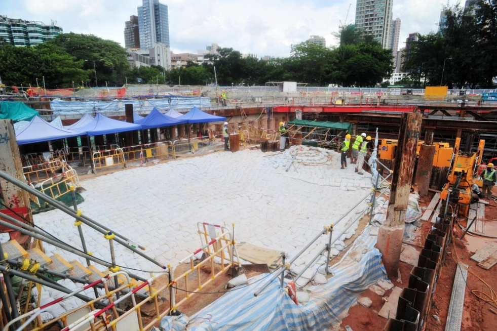
T1保護牆安裝後情況
