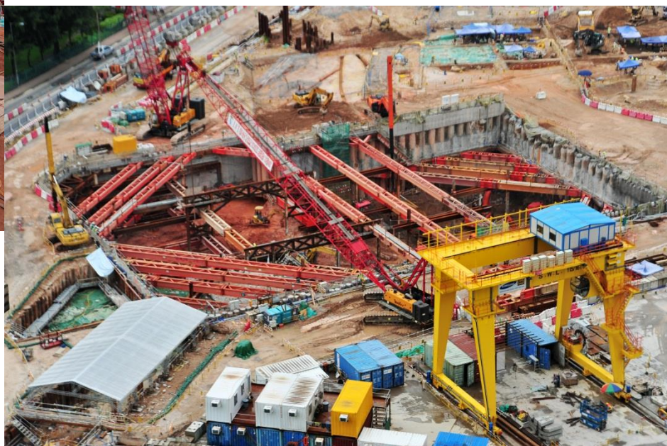
豎井區域現況
